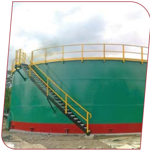
Tanques de almacenamiento de agua
